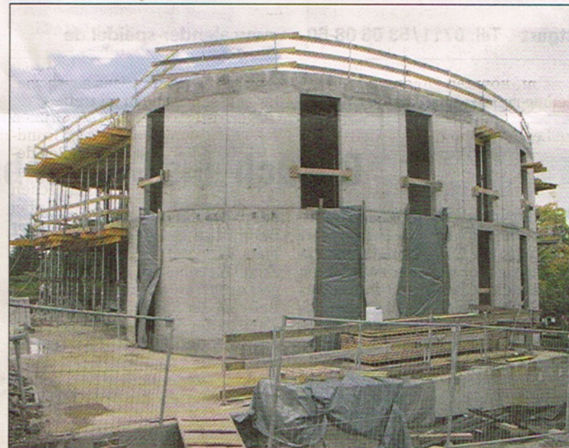
Das erste Gebäude mit Flachdach und fünf Wohnungen ist nun errichtet. Links daneben entsteht das zweite Gebäude mit acht Wohnungen.
